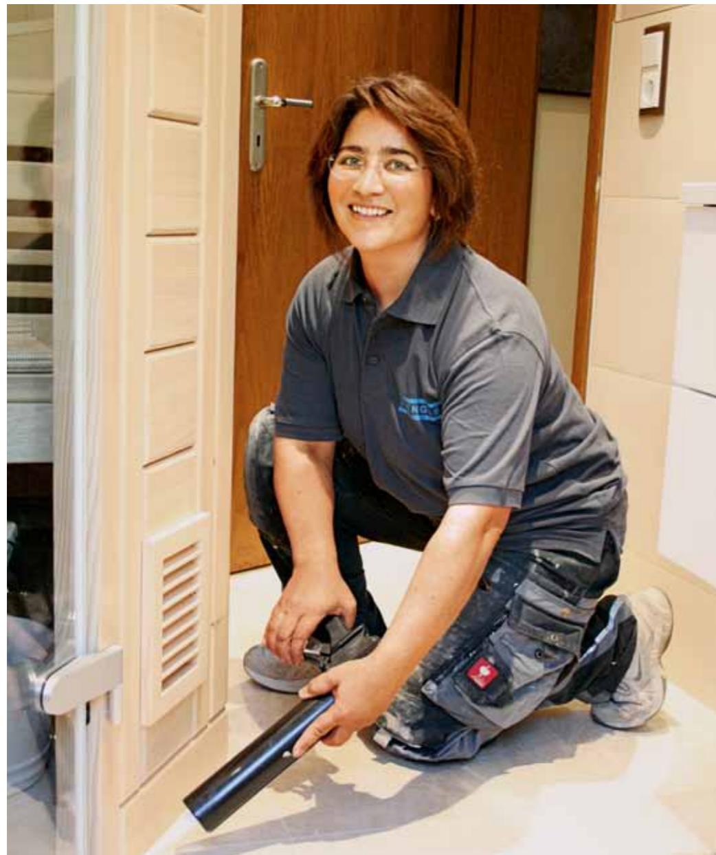
Für Patricia Bombala ist Fliesenlegerin der Traumberuf. Die Baustellen wickelt sie in der Regel allein ab.
